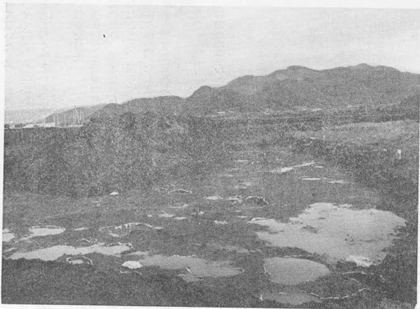
春日町七日市区の耕地整備工事現場で発掘された「柱根穴」の模様
