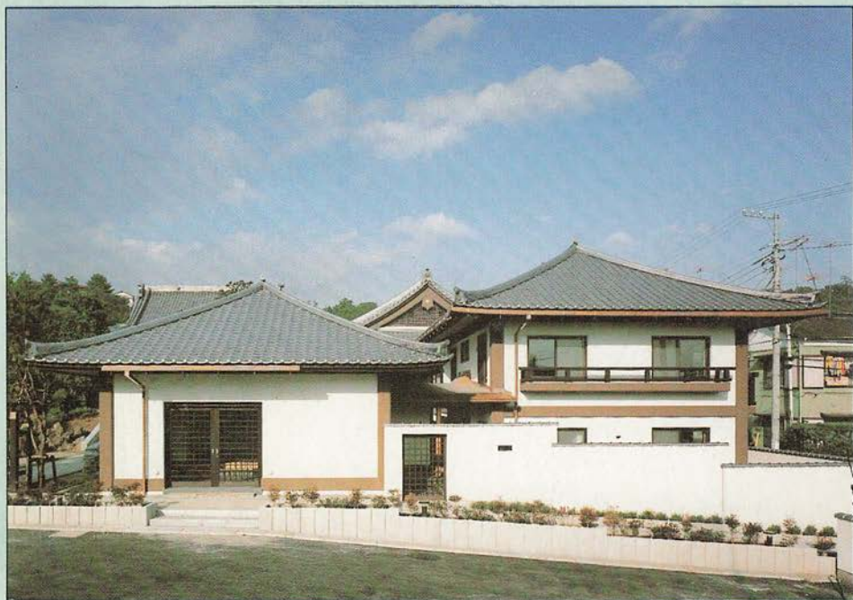
横浜 東光寺 客殿及庫裡 昭和59年当社施工
