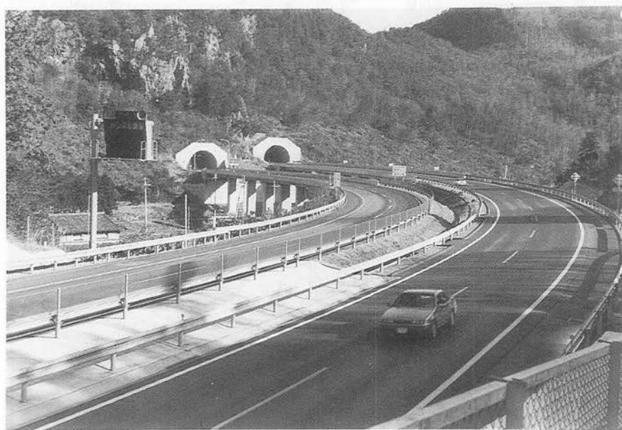
舞鶴自動車道 春日町多利・日が奥トンネル附近
