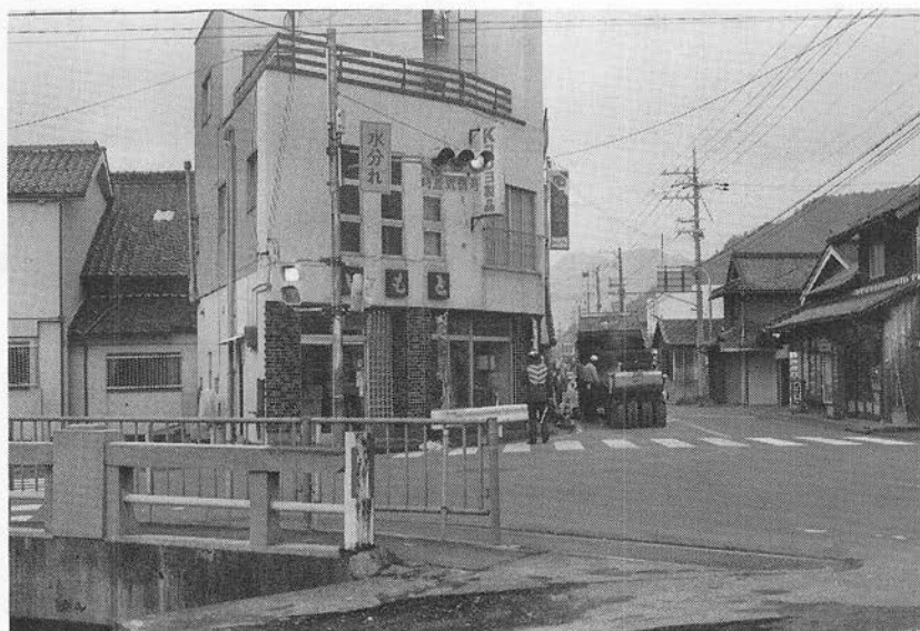
水分橋側で下水道工事、流れは変わるか？（撮影：徳田八郎衛）
