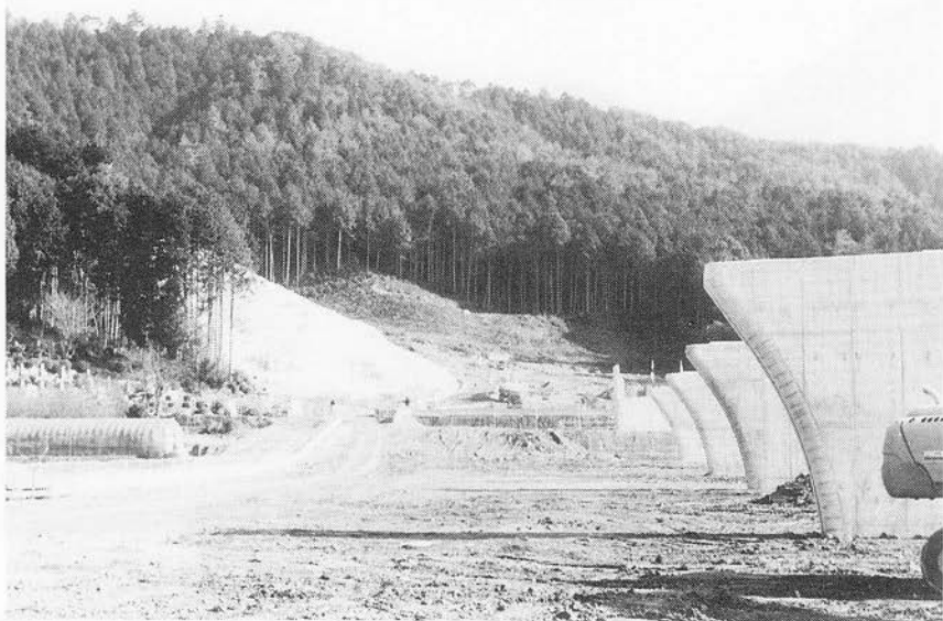
横田遺跡出現で但馬への 高速道路工事がストップ (成松方面より遺跡を見る)
