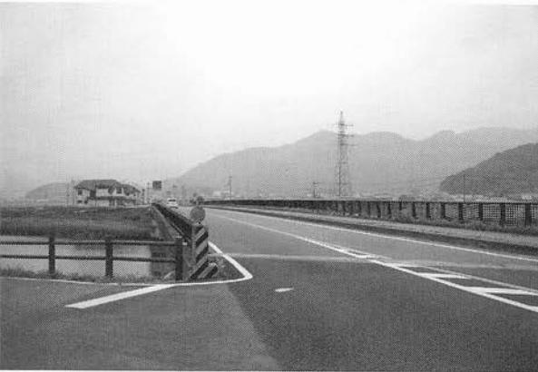
拡幅された山南町 井原大橋
