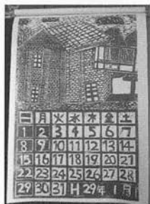
H29/1月・時代を先取りしたレンガ造りの発電所跡
