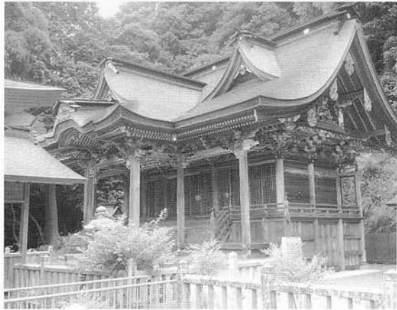
本殿正側面（南東より見る）
