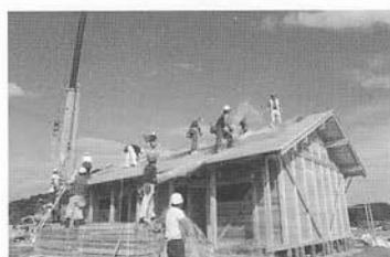
仮設住宅の断熱材に茅を利用
