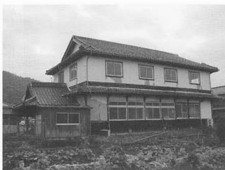
解体前の旧崇広館（旧水上郡役所）
